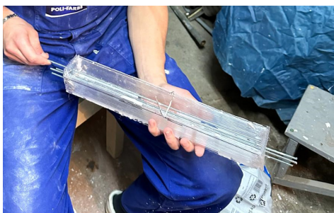
Figura 5. Cofragul pentru grinzi
